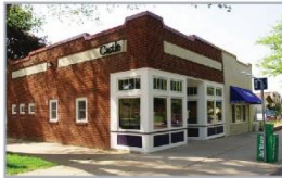
2600 Johnson St. NE Minneapolis, MN 55418 P) 612-789-8509
