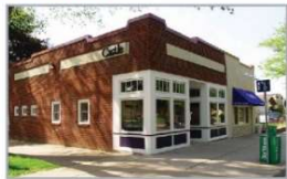
2600 Johnson St. NE Minneapolis, MN 55418 P) 612-789-8509
